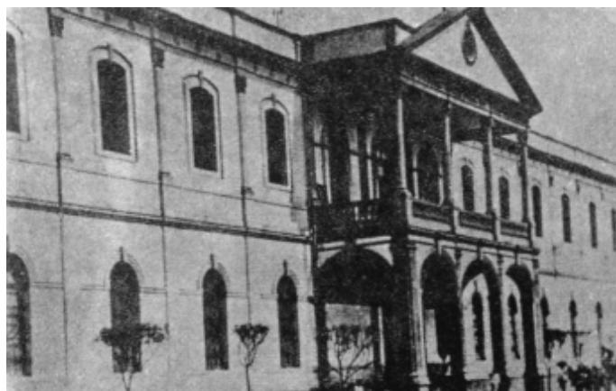
Figura 6. Hospital Militar de Instrucción.
