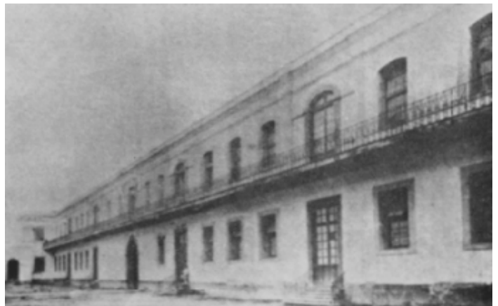
Figura 2. Hospital Militar de Instrucción, 1903-1906.
