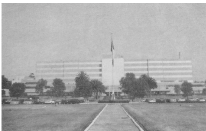
Figura 13. Fachada del "Hospital Central Militar" actual.
