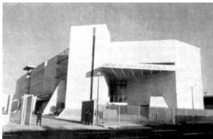
Figura 11. Fachada principal de la unidad de especialidades médicas.
