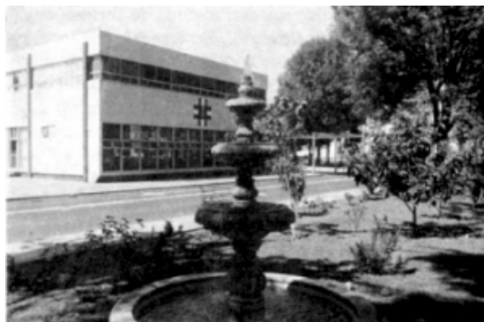
Figura 10. Angulo lateral de la fachada principal del hospital militar regional.
