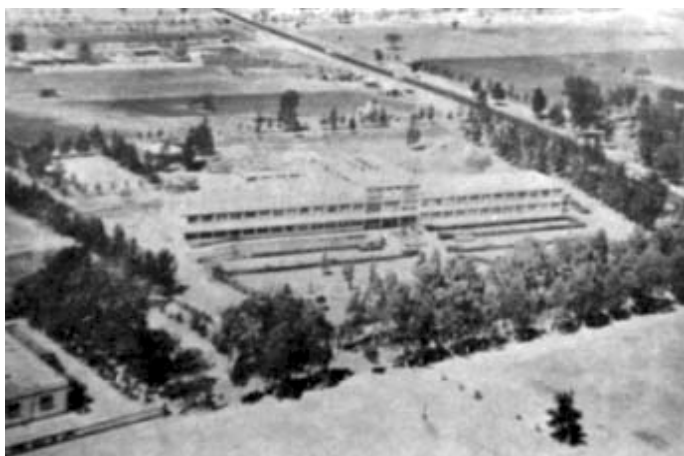
Figura 4. Vista aérea del Hospital Militar en su ubicación actual en el año de 1960.
